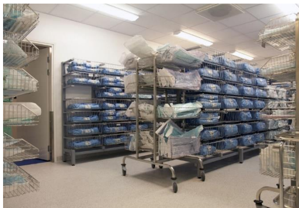
Figura 1: Central de Material Esterilizado – CME
