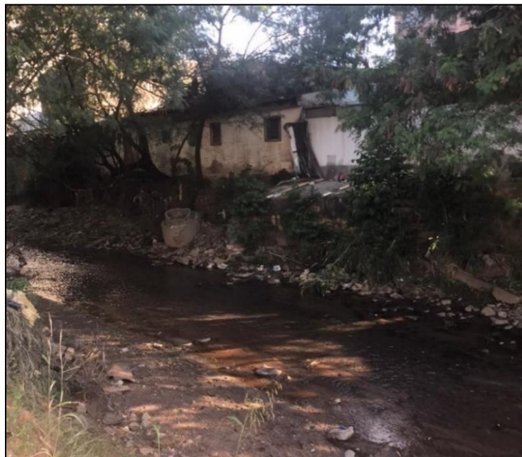
Foto 1 - Edificações a margem do rio Góis
